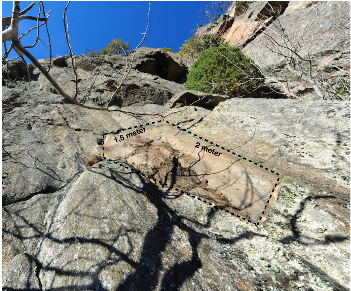
Bild 6: Platsen där stenformationen tidigare satt ihop med klippan, från platsundersökningen 24 oktober.
